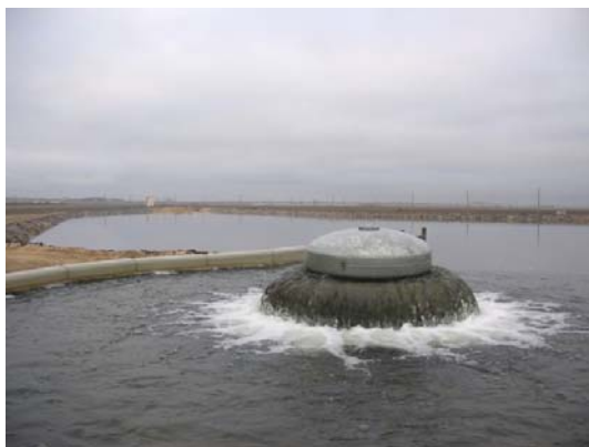
Figuras 3 a) y b)- Cabecera del dispositivo de AR y balsa de decantación de la que parten ambos canales.
